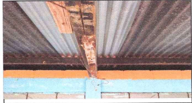
Foto 2: lijar y pintar la estructura metálica
